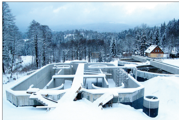
Szklarska Poręba - budowa w zimowej scenerii
